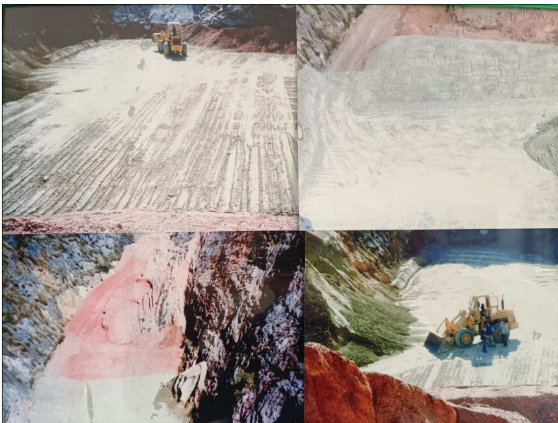
Documentazione fotografica relativa alla messa in posto dell'argilla bentonitica
